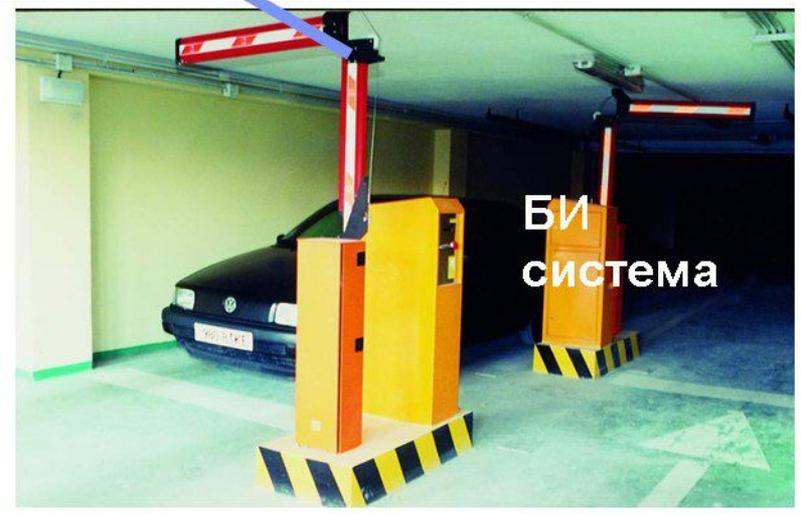
Шлагбаум на одном шарнире – хорош в условиях хорошего пространства вокруг, и непригоден в стеснённых условиях. Но он же но уже с двумя шарнирами вполне уме ствен в стеснённых условиях.
